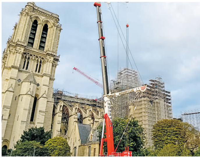
▲巴黎聖母院重建修繕工程進行中。
